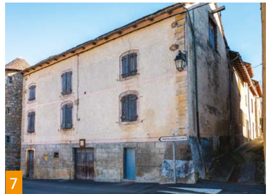
5. façade ocre rouge et encadrement peint à la chaux blanche (cause Noir). 6. Façade d'une habitation dans le village, avec chaîne d'angle peinte en trompe l'œil (mont Lozère). 7. Décor d'architecture en trompe l'œil : parement ocre jaune clair, bandeaux horizontaux et entourages de fenêtres ocre rosé, chaîne d'angle harpée avec pierres à bossage plat de couleur ocre jaune foncé et gris, soubassement imitant des pierres de taille, de couleur grise (chaux et noir de fumée ou de vigne), gorges du Tarn.
