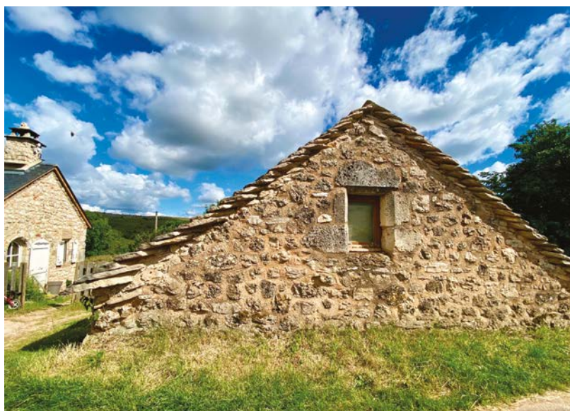
▲ Exemples de rejointoiements sur la cause Méjean. ►
