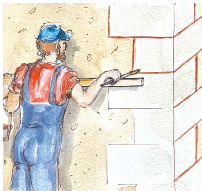
Réalisation d'une chaîne d'angle harpée. ▲
