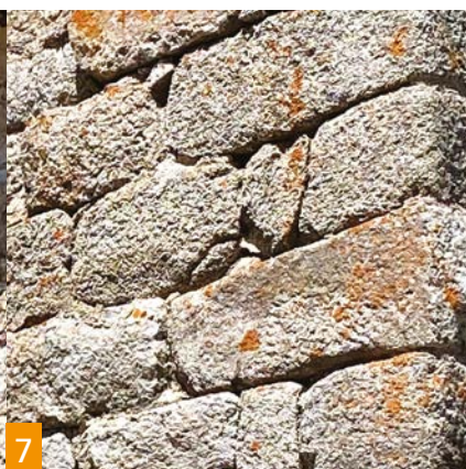
Ferme sur le mont Lozère, vue générale (5) et détails (6, 7) Les joints vifs sur les bâtiments anciens sont le résultat de l'usure de l'enduit et des joints et non d'une façon de bâtir. Les vestiges de l'enduit d'origine sont le plus souvent visibles sous l'avancée de toiture (6), mieux protégée. L'usure fait disparaître le mortier entre les pierres (7).
