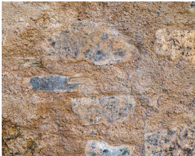
▲ Enduit de rejointoiment neuf, à fleur des têtes de pierres sur maçonnerie mixte (Journée de formation au château de Florac).
