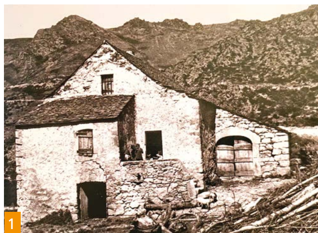
1. Habitat d'altitude protégé par un enduit économique présent sur la façade et sur le pignon. Ferme de La Foux (Aigoual) en 1903.
