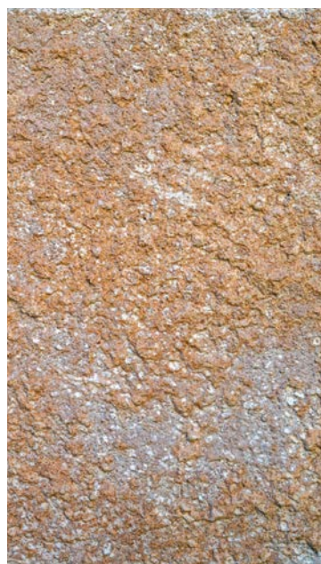
▲ Finition jetée au balai : texture grenue et régulière (Journée de formation au château de Florac).
