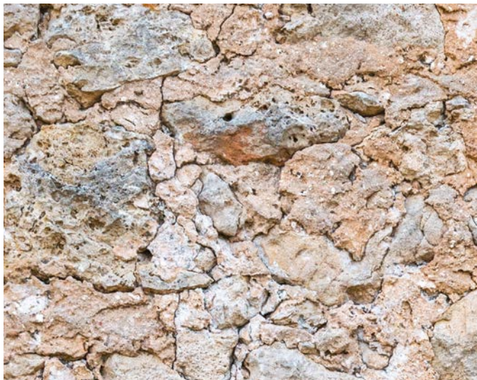
▲ Texture d'un enduit ancien de rejointoiment sur mur en dolomie.
