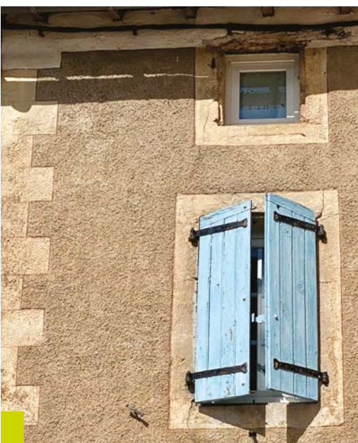
▲ Finition « jetée au balai » avec une alternance de texture et de couleur : le mur est « matié », la chaîne d'angle et les encadrements d'ouvertures sont lissés et peints à la chaux et soulignés d'un filet ocre rouge.
