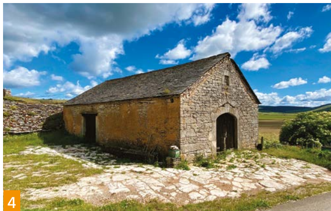
3 et 4. Grange sur le causse Méjean, au début du XX e et aujourd'hui : le mur de l'entrée, remanié lors du changement de fenêtre et de la réfection de la toiture, n'a pas conservé son enduit. L'enduit est toujours présent sur le mur latéral.
