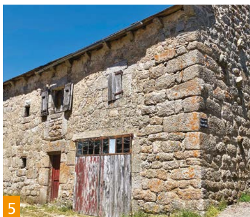
Ferme sur le mont Lozère, vue générale (5) et détails (6, 7) Les joints vifs sur les bâtiments anciens sont le résultat de l'usure de l'enduit et des joints et non d'une façon de bâtir. Les vestiges de l'enduit d'origine sont le plus souvent visibles sous l'avancée de toiture (6), mieux protégée. L'usure fait disparaître le mortier entre les pierres (7).
