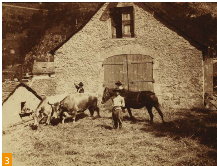
3 et 4. Grange sur le causse Méjean, au début du XX e et aujourd'hui : le mur de l'entrée, remanié lors du changement de fenêtre et de la réfection de la toiture, n'a pas conservé son enduit. L'enduit est toujours présent sur le mur latéral.
