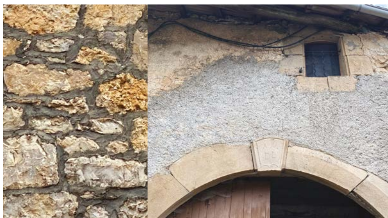
▲ Joints au ciment.
