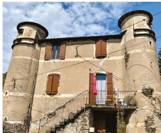
◀ Façade historique avec bandeaux horizontaux et enduits des deux tours colombiers lissés et peints en blanc, à conserver et restaurer (vallée Française).
