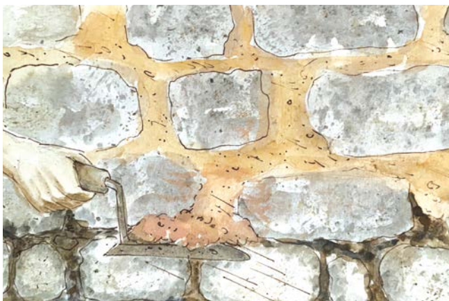
▲ Rejointoiment sur un mur en granite. Les joints sont « beurrés » c'est-à-dire bien garnis. Après le rejointoiment, on peut brosser les pierres pour les nettoyer : on évitera les joints qu'il ne faut surtout pas creuser.
