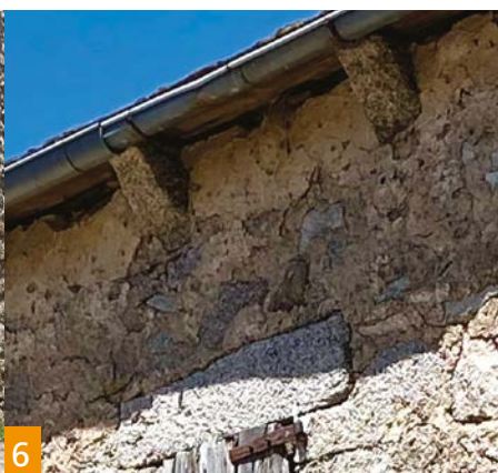
Ferme sur le mont Lozère, vue générale (5) et détails (6, 7) Les joints vifs sur les bâtiments anciens sont le résultat de l'usure de l'enduit et des joints et non d'une façon de bâtir. Les vestiges de l'enduit d'origine sont le plus souvent visibles sous l'avancée de toiture (6), mieux protégée. L'usure fait disparaître le mortier entre les pierres (7).
