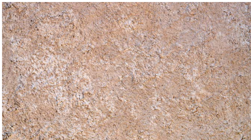
▲ Enduit « jeté-recoupé » : texture grenue.
